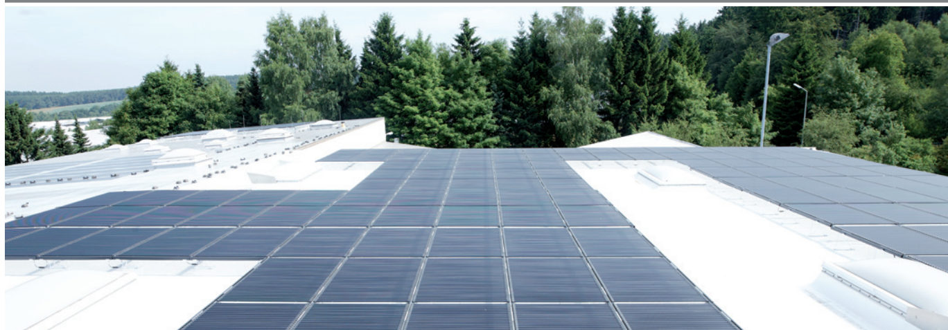
▲ SOLYNDRA® Solar na nové, bílé střešní izolaci EVALON®
